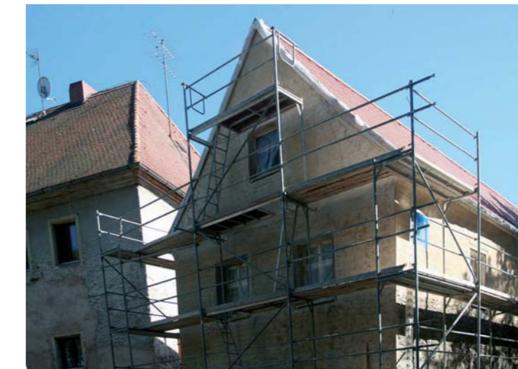
Umbau des Torhauses in Leupoldsdorf
