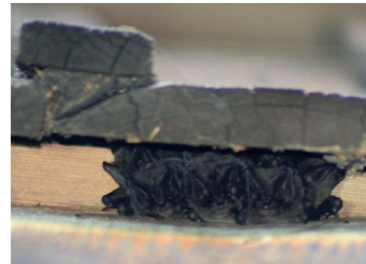
Mopsfledermäuse hinter der Holzverschalung einer Scheune
