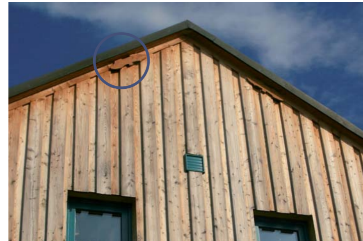
Holzverkleidung über einer Doppelgarage in Schönbrunn
