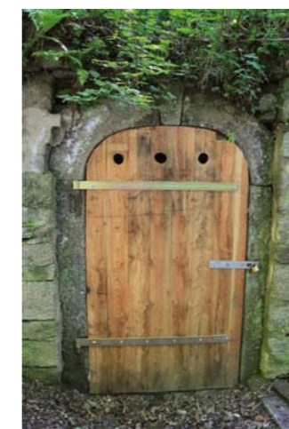
unterschiedliche Ausformungen von Einflügen in sanierten Türen
